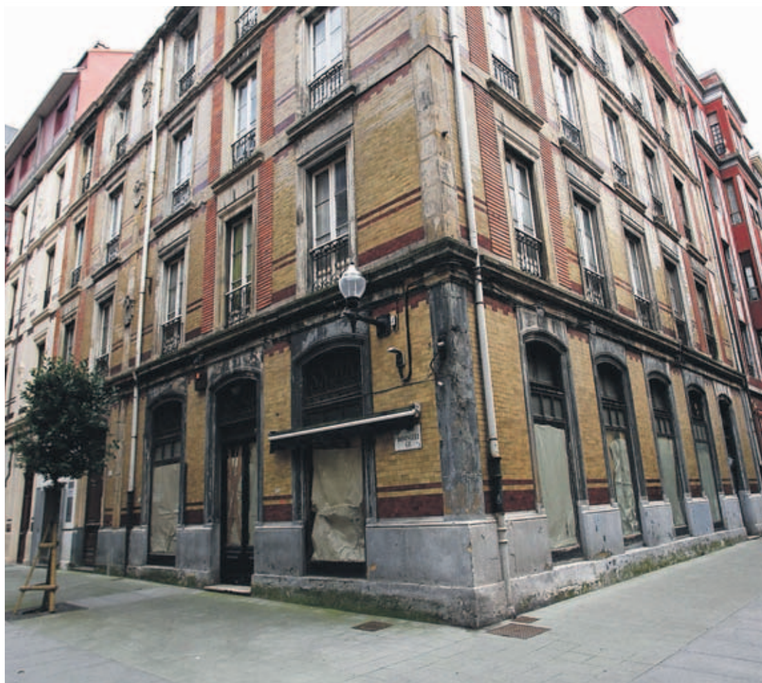
Edificio del antiguo bar El Molinucu, en la esquina de las calles de La Merced y Domínguez Gil. | ÁNGEL GONZÁLEZ
