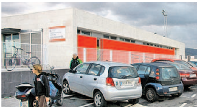
Instalaciones del campo municipal de Los Pericones. | MARCOS LEÓN
